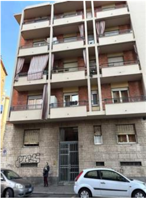
Dettaglio facciata verso via Chivasso
